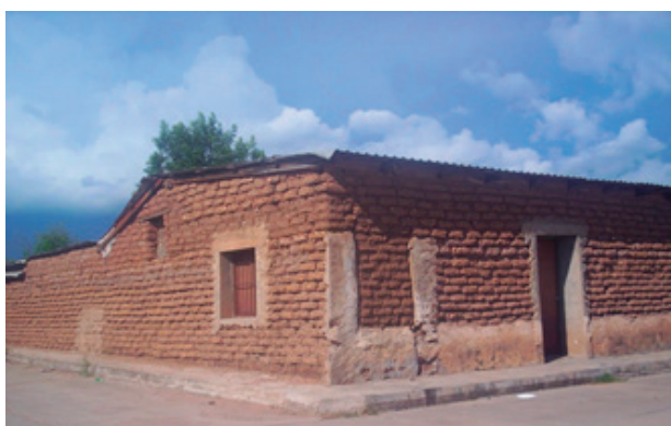
Figura 2. Vivienda construida a base de bloques de adobe.
